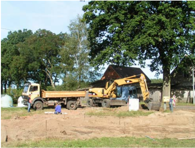
Bau der Buswendeschleife in Volkwig
